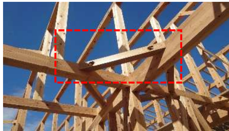
芯去り材製品を公共建築物に使用
