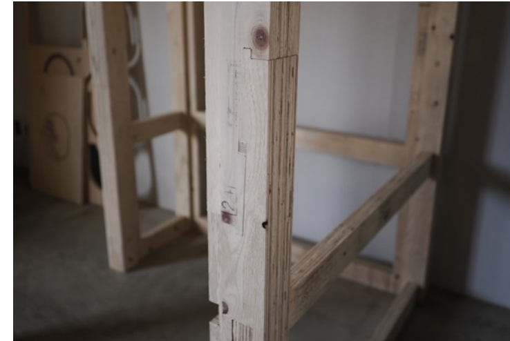
金輪継ぎで合板を接合し柱部分を製作
