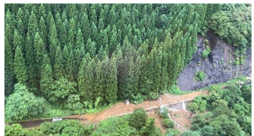
山腹崩壊による土砂流出 (比内町中野)
