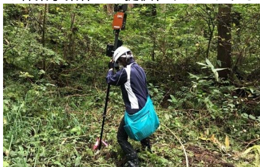
地上レーザ計測機器の導入
