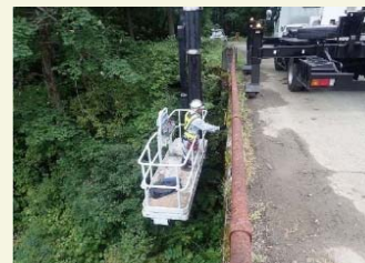
林道橋梁の点検
