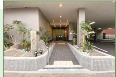
出入口前の手すり付きスロープ
