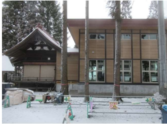
完成後の覆屋
