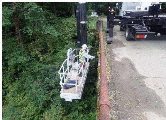
既設林道における橋梁の点検
