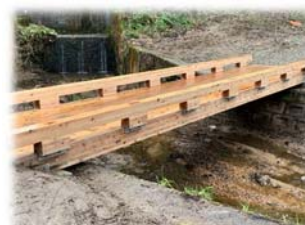
公共土木事業等における木材利用の推進 （岩神ふれあいの森 CLT木橋）
