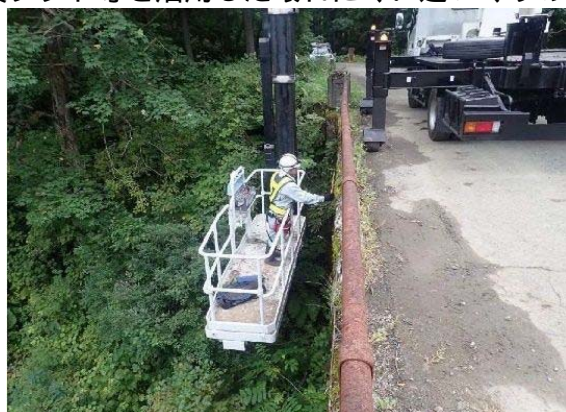
既設林道における橋梁の点検
