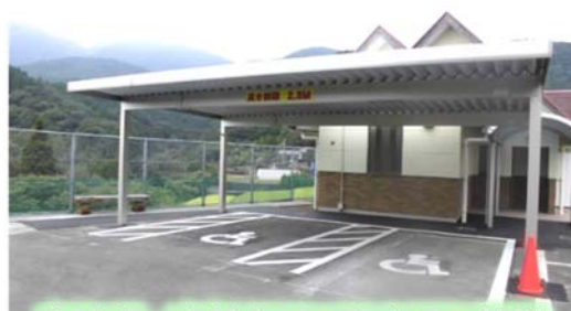
身障者・高齢者用の駐車場を整備
