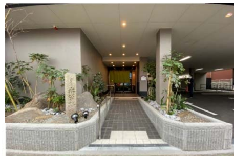
出入口前の手すり付きスロープ
