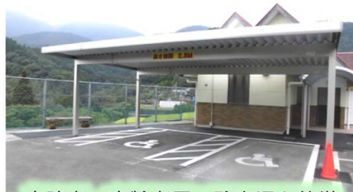
身障者・高齢者用の駐車場を整備
