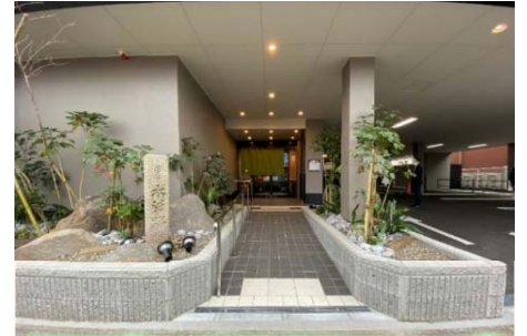
出入口前の手すり付きスロープ
