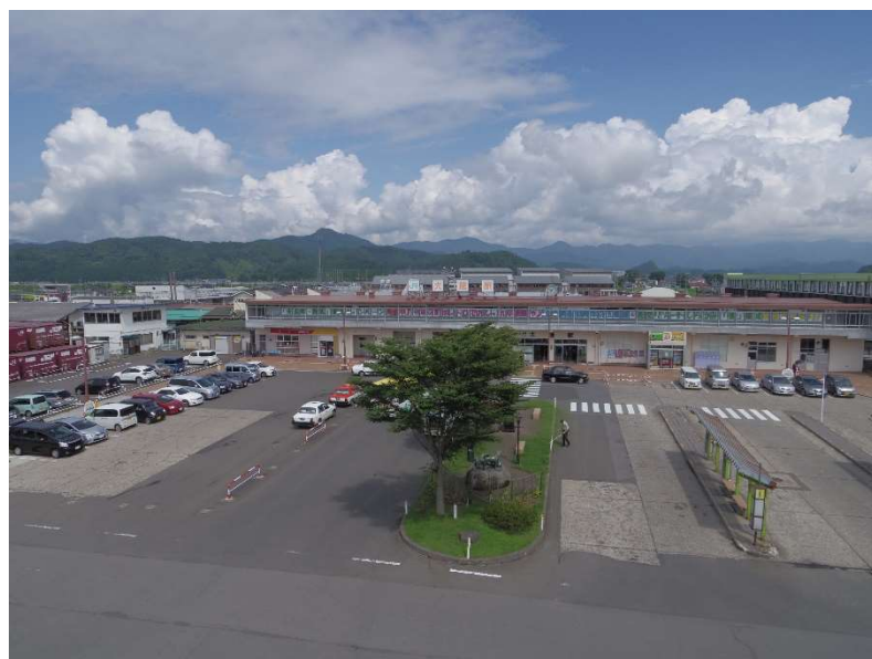
【旧駅舎、駅前広場】
