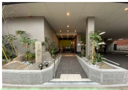
出入口前の手すり付きスロープ
