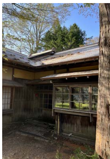
屋根応急処置 (令和6年1月19日完了)
