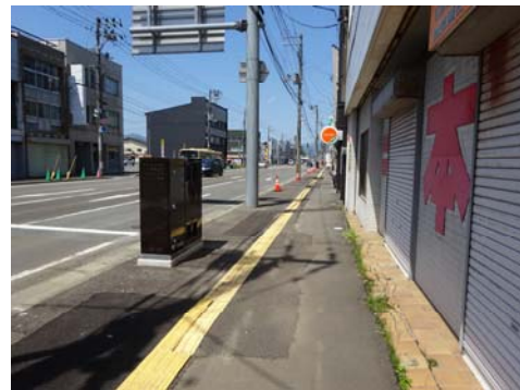
電線共同溝本体工事【下り線】 (完了後)
