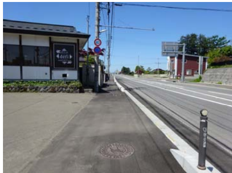
豊町地区電線共同溝本体工事【上り線】 (完了後)
