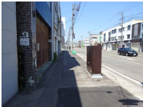
電線共同溝本体工事【上り線】 (完了後)
