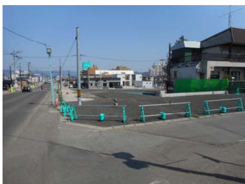
歩道融雪設備工事(着手前)
