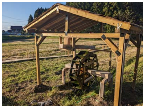
水車・小屋・通路設置 (駒橋会)
