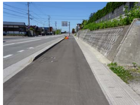
豊町地区電線共同溝本体工事【下り線】 (完了後)
