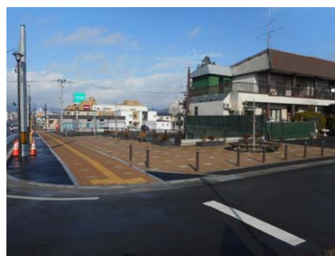
歩道融雪設備工事(完了後) 抜柱は令和7年度以降に施工予定
