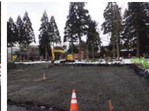
路床置換工(岩ずり)
