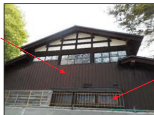
(写真) 北側鉄板サイディング張りの外壁
