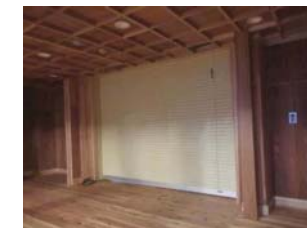
覆屋防火シャッター設置
