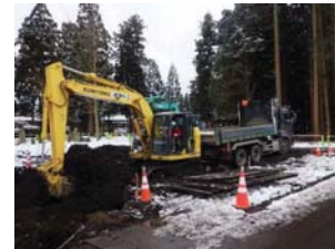
駐車場敷地(表土剥ぎ取り)
