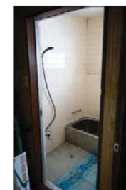
(写真) 既存浴槽等は撤去し、外部物置に改修
