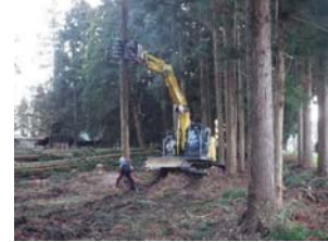
支障木伐木状況
