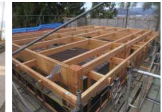
覆屋集成材組立状況
