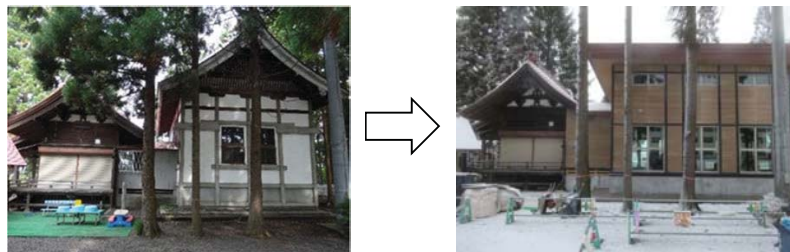
左から拝殿・幣殿・覆屋（南側から撮影）
