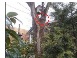
(写真) 樹木で受けている架空電話線
