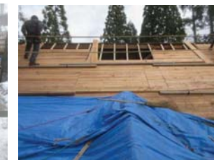
拝殿屋根葺き替え状況
