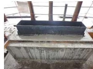
功德碑台座コンクリート
