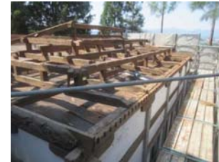
既存覆屋解体状況
