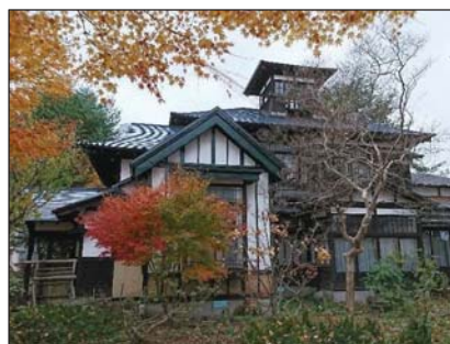
(写真) 桜櫓館の現状 (長尺横葺き、瓦棒葺き)
