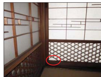
(写真) 組子の補修や建具調整
