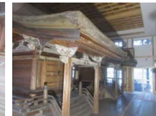
覆屋内装仕上げ
