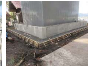
覆屋基礎コンクリート打設状況
