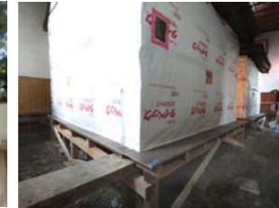
覆屋床板切断撤去完了
