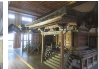
覆屋内部完成（重要文化財二社）
