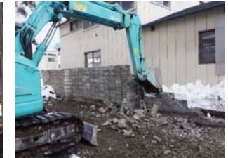
ブロック塀撤去状況
