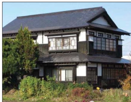
(参考写真) 平葺き (一文字葺き) 屋根の住宅
