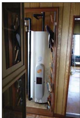
(写真) 電気温水器は撤去
