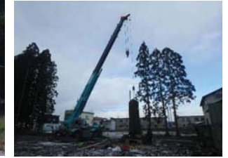
功德碑移設状況(クレーン吊)
