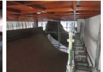
本殿養生内部足場組立完了
