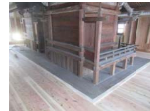
覆屋床仕上げ
