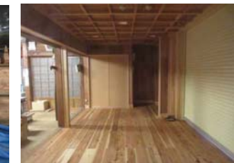
幣殿内装仕上げ
