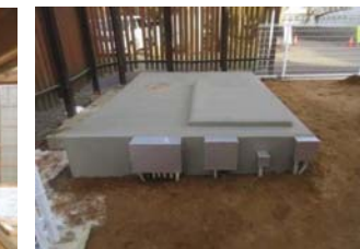
消火水槽上屋解体状況
