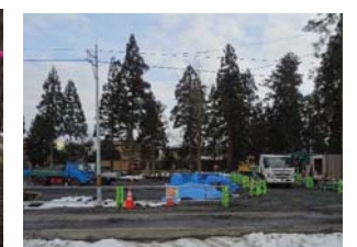
支障電柱(移設後)
