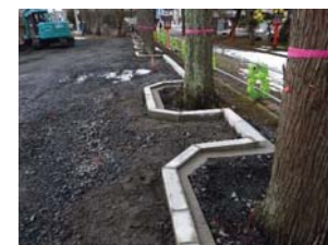
縁石工(地先境界布設)
