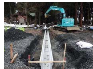
排水工(側溝布設)
