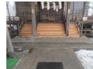
拝殿階段工改修完了
