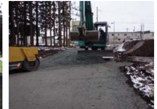
曳山車通路(路盤工)
