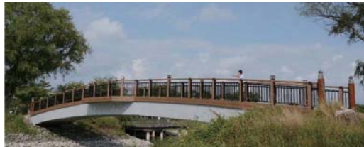
庁舎と調和を図り、木橋風デッキを設置
