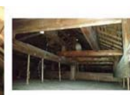
当初屋根(小屋裏状況)
