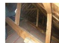
覆屋根(小屋裏状況)
