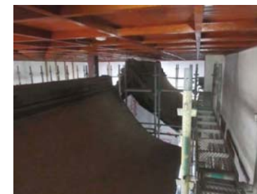
本殿養生内部足場組立完了
