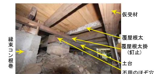
若宮八幡宮本殿の床下
