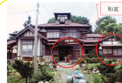
(移転前) 東面建物全景
