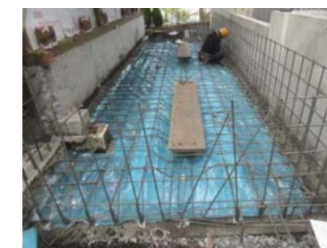
幣殿基礎鉄筋配筋状況
