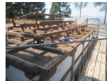
既存覆屋解体状況
