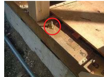
基礎と土台をアンカーボルトで固定
