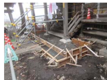
拝殿土間コンクリート打設状況
