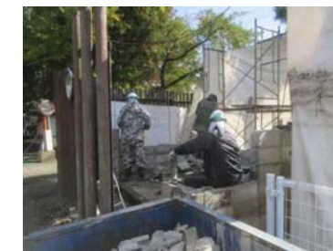
消火水槽上屋解体状況
