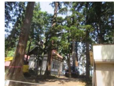
支障木伐採状況（クレーン吊）
