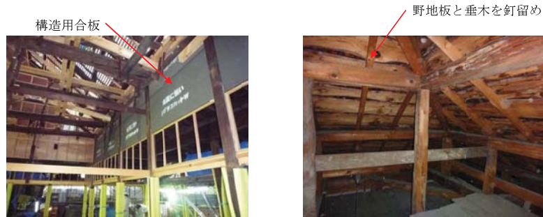
一部既存壁を構造用合板で補強
