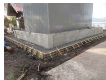
覆屋基礎コンクリート打設状況
