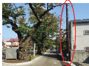
電柱電線類の統合 景観色の鋼管柱に修景 【統合移設後】
