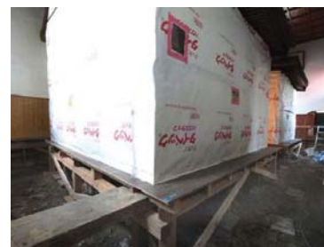
覆屋床板切断撤去完了
