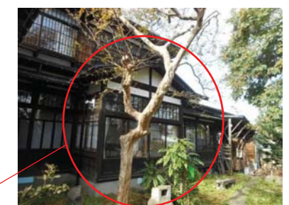
(現在) 東面建物外観
