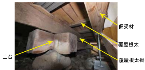
正八幡宮本殿の床下
