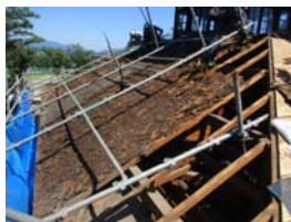
屋根下地撤去
