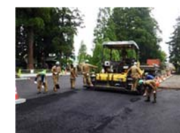
駐車場アスファルト舗装工
