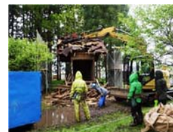
古四王神社解体
