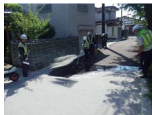
薄層カラー舗装（樹脂系すべり止め舗装） 庵治石使用（クールグレー）
