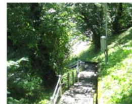
北側階段の改修(H29 年度)
