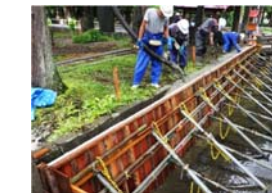
堀壁補修(化粧型枠コンクリート擁壁)
