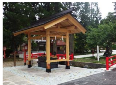
手水舎(完成写真)
