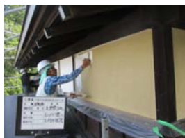
外壁漆喰塗仕上げ
