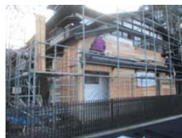
北側外壁下見板復元
