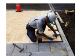
耐火レンガ設置(お焚き上げ場)
