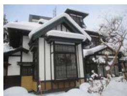
外部復元完了(東側)
