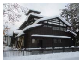
外部復元完了(北側) サイディング張り→下見板張り
