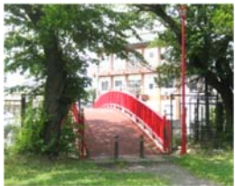
落橋防止装置設置(H26 年度)
