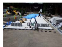
参道美装化(平板敷工)
