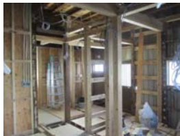
新設補強柱梁組
