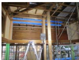
大広間鉄骨梁補強
