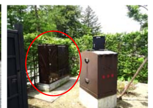
地上機器を民地へ設置
