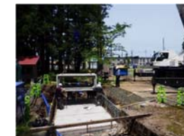
ボックスカルバート設置(辛丑橋)
