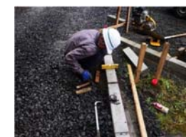
地先境界ブロック設置
