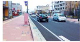
(2) 安全な歩道空間
