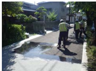
薄層カラー舗装（樹脂系すべり止め舗装） 庵治石使用（クールグレー）
