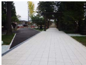
曳山車通路及び参道美装化(完成写真)
