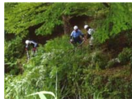
土塁斜面の不用木除去
