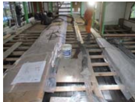
床下基礎コンクリート打設
