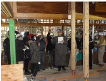
大館市桜橋館耐震改修現場研修会
