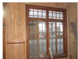
耐震金物取付
