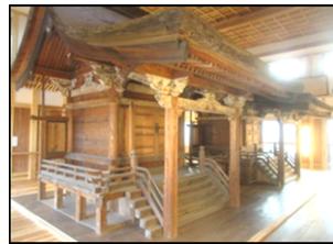
大館八幡神社覆屋完成
