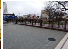
令和6年11月22日 堀周辺部修景整備完成 (木橋風デッキ)
