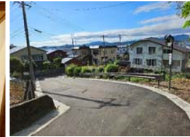
令和6年9月30日 金坂地区道路美装化完成
