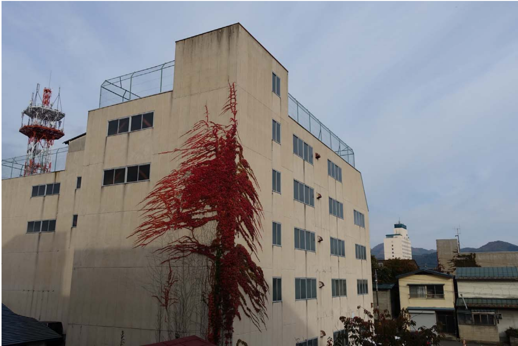
51. 竹村駐車場のツタ（解体前）
