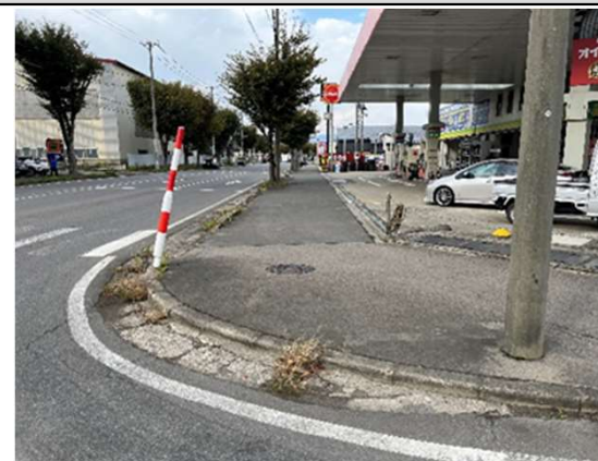
③施工予定箇所 (大館駅入口交差点)
