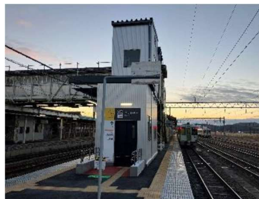
エレベーターの設置 (ホーム内)
