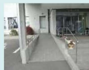
出入口の段差解消 事業費：30万円程度
